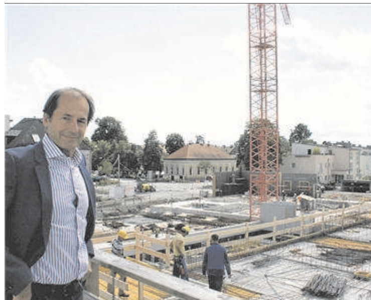
Herbert Pinzolits ist zufrieden mit dem Baufortschritt. Bis Mai sollte das Hotel übergeben werden können. Die Wohnungen im Donaupark könnten bis Jahresende bereits verkauft sein. Fotos: Gruber-Dorninger
